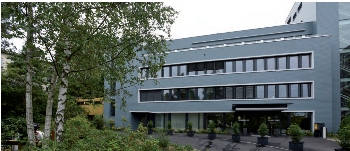
Überregionale Ausstrahlung: Der «Sunnepark» in Grenchen ist ein Wohn-, Pflege-, Gesundheits- und Bildungszentrum mit vielseitigem Angebot.
