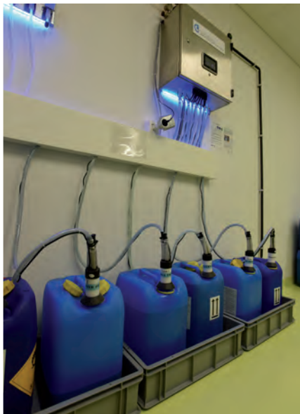
Dosierung leicht gemacht: Die Gebinde sind einfach an der Dosieranlage von der Chemie AG Bern anzuschliessen und schon steht immer die richtige Portion Waschmittel bereit. Der Bestellprozess ist optional automatisierbar. Die leeren Behälter nimmt die Chemie AG zurück und recycelt sie.
