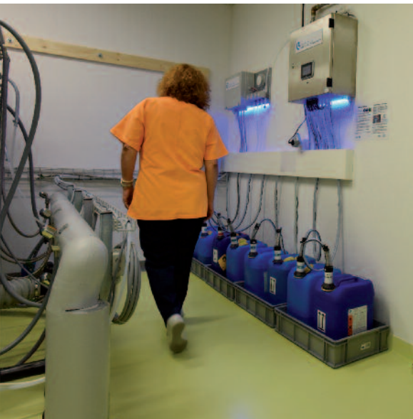
Dosierung leicht gemacht: Die Gebinde sind einfach an der Dosieranlage von der Chemie AG Bern anzuschliessen und schon steht immer die richtige Portion Waschmittel bereit. Der Bestellprozess ist optional automatisierbar. Die leeren Behälter nimmt die Chemie AG zurück und recycelt sie.
